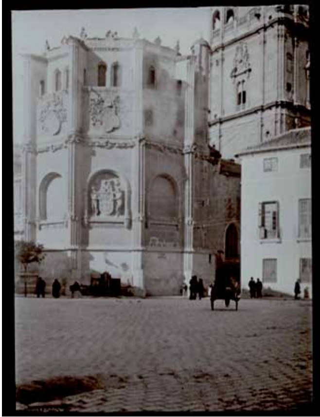
Exterior de la Capilla de los Vélez / Archivo del P. de la Alhambra y Generalife, F-001034
