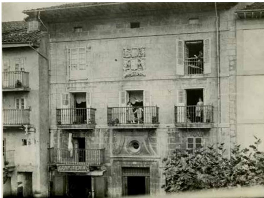
Vista de la casona palacio de la familia de la Mar, en Laredo, Cantabria
