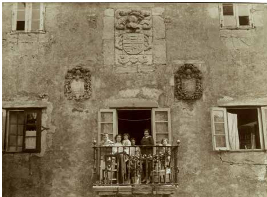
Detalle de la fachada de una casa, con escudos nobiliarios, en Laredo, Cantabria
